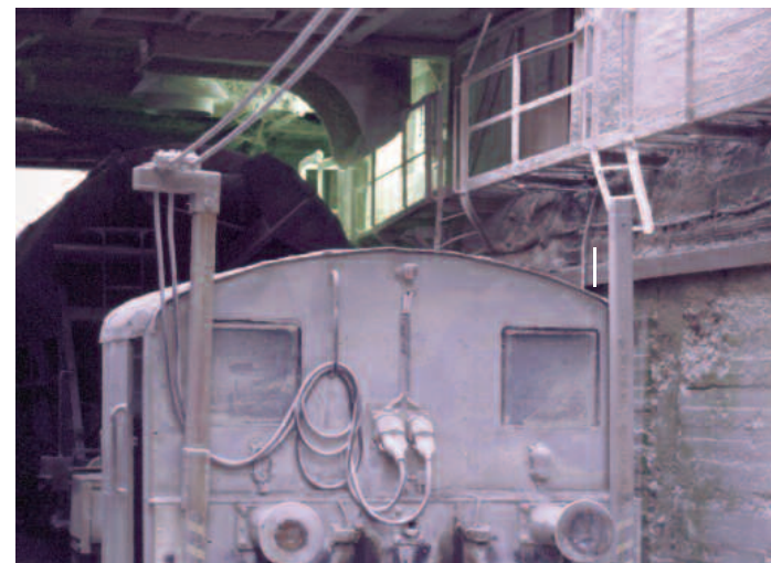
Detail der Kabelzuführung der LKM 249884
