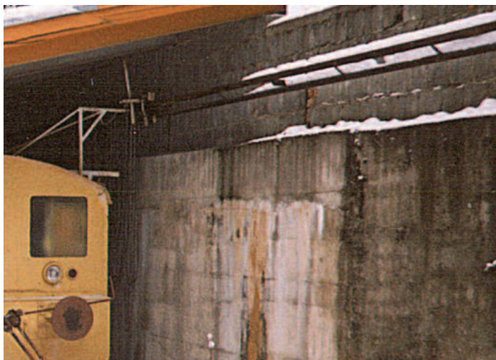
Detail der seitlichen Stromzuführung der LKM 251058 Splittverladung Kieswerk Holhau (Erzgebirge)
